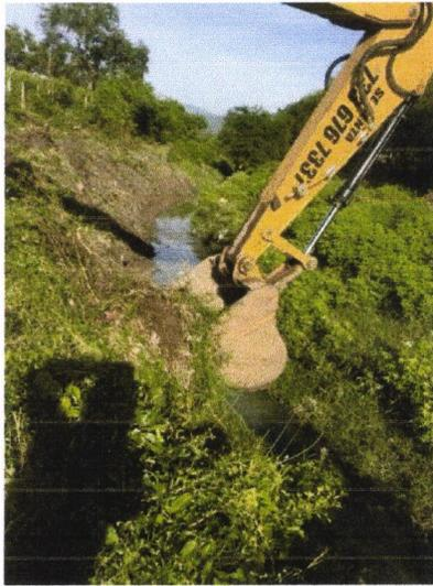
LIMPIEZA Y DESASOLVE CON EQUIPO MECANICO, EN CANALES Y/O BARRANCA, EN MATERIAL TIPO I-"A", SATURADO CON PRESENCIA DE BOLEO, CON PROFUNDIDAD DE 0.00 A 2.00 MTS, INCLUYE: EQUIPO Y OPERACIÓN.
