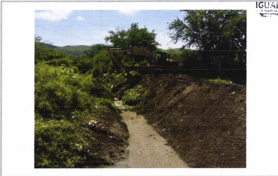
LIMPIEZA Y DESASOLVE CON EQUIPO MECANICO, EN CANALES Y/O BARRANCA, EN MATERIAL TIPO I-"A", SATURADO CON PRESENCIA DE BOLEO, CON PROFUNDIDAD DE 0.00 A 2.00 MTS, INCLUYE: EQUIPO Y OPERACIÓN.
