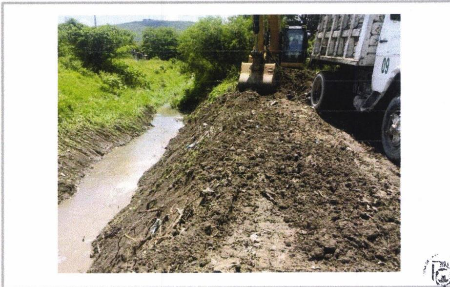
ACARREO DE ESCOMBROS PRODUCTO DE LA EXCAVACION Y/O DEMOLICION EN KILOMETRO SUBSECUENTE, INCLUYE: EQUIPO Y OPERACION.
