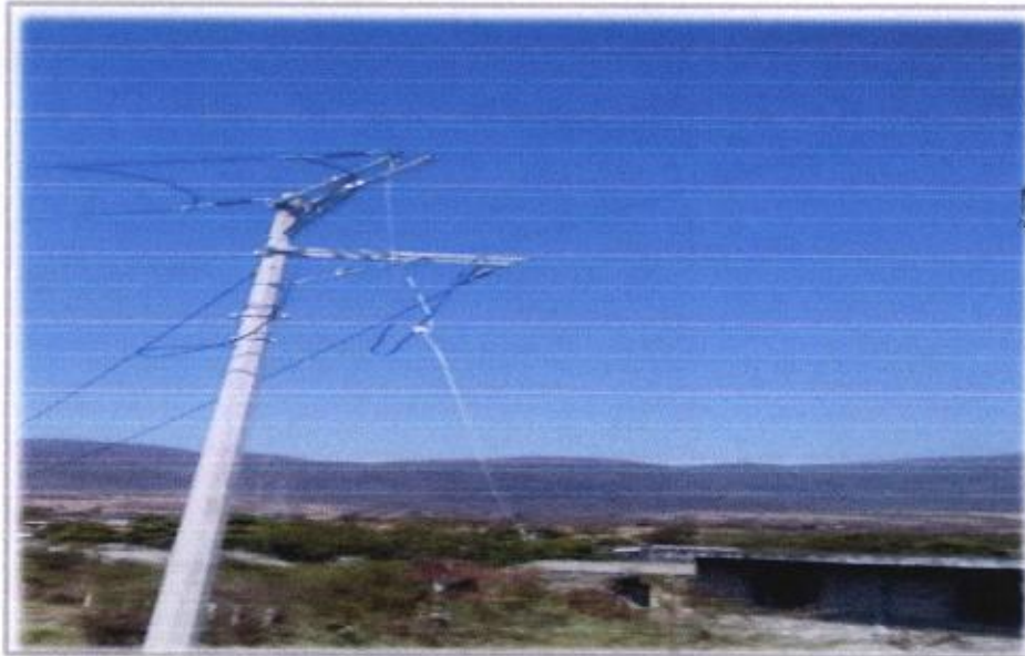
EQUIPAMIENTO DE POZO
