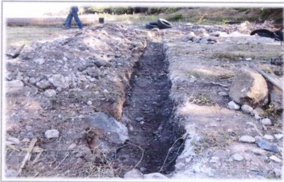
EQUIPAMIENTO DE POZO
