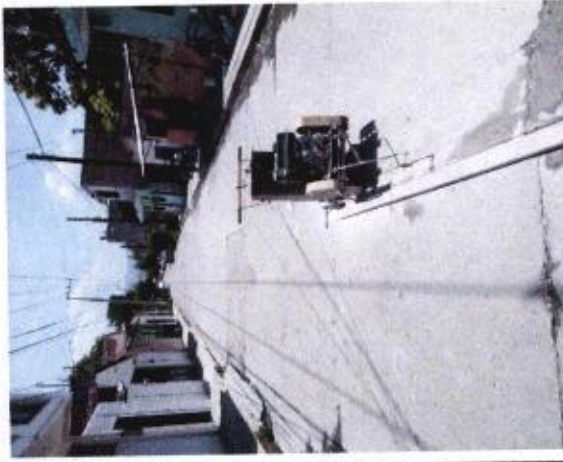
CORTE DE PAVIMENTO HIDRAULICO, CON CORTADORA DE DISCO DE DIAMANTE, INCLUYE: MATERIALES, MANO DE OBRA, EQUIPO Y TODO LO NECESARIO PARA SU CORRECTA EJECUCION.
