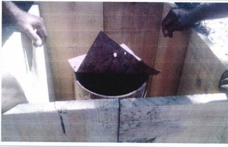
SUMINISTRO Y COLOCACION DE SELLO CEMENTADO
